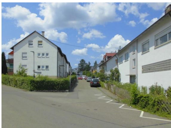
Foto 9: Wohnbebauung im Westen (Nikolaus-Lenau-Straße)
