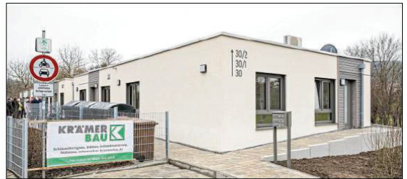
Zugang von der Jahnstraße aus zu den drei einstöckigen Gebäuden.
