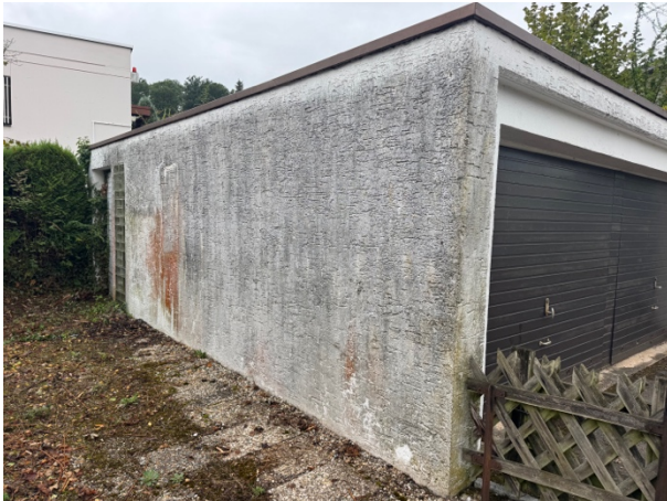
Abb. 10: Blick auf die Garage ohne Nestbaumöglichkeit oder Spaltenquartiere aus Südosten.
