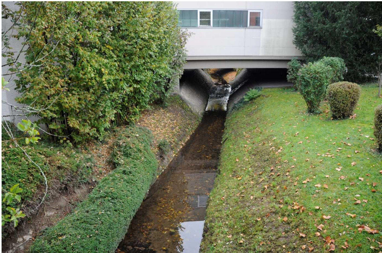
Abbildung 1: Naturfern ausgebauter Gewässerabschnitt des Zipfelbachs auf Höhe der Brückenstraße (24.10.2017).
