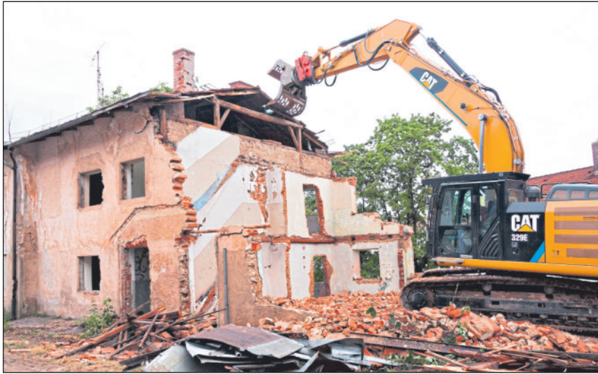
Abbruch eines Gebäudes.
