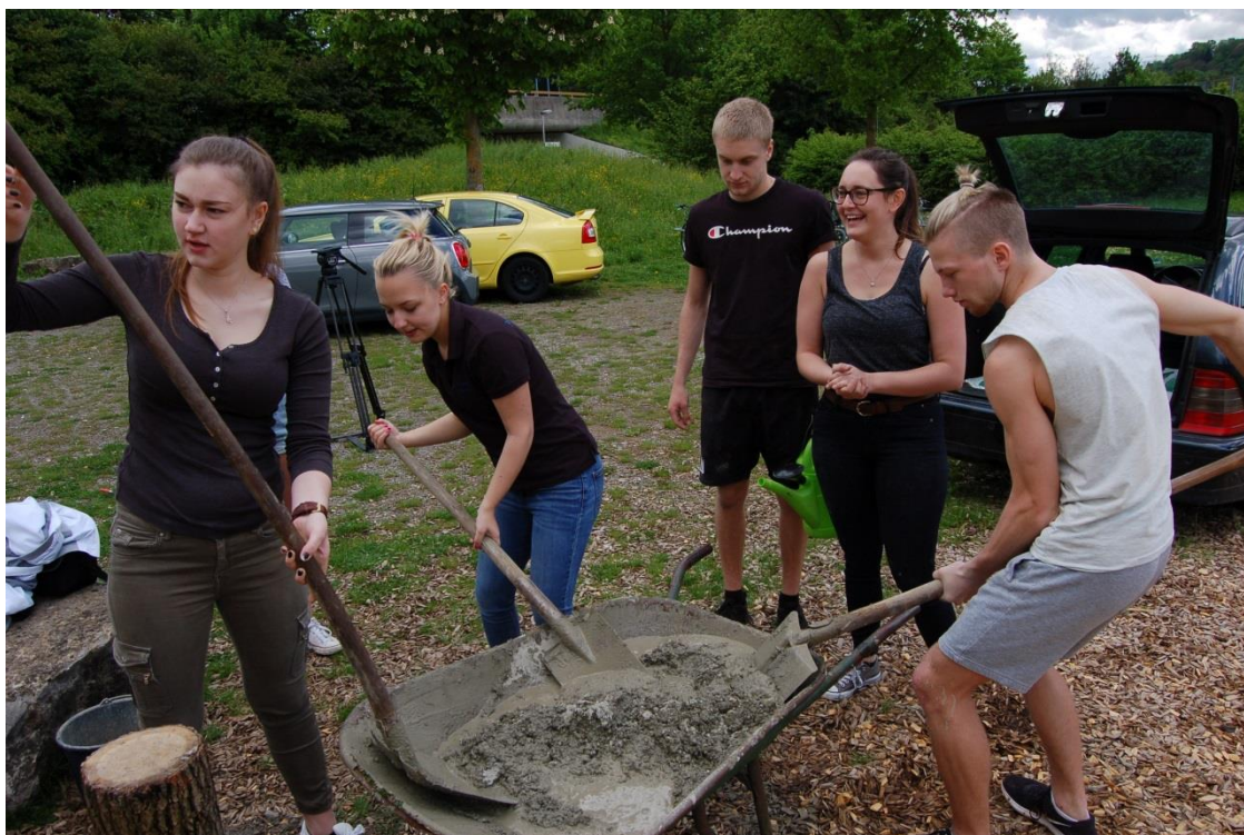
Die Jugendlichen mischen den Beton für das Fundament.
