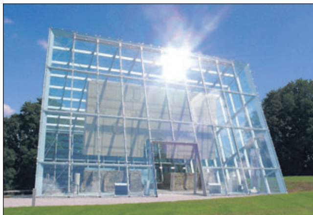
Nächste Station war das Limestor in Dalkingen, das sich hinter einem Schutzhaus befindet.
