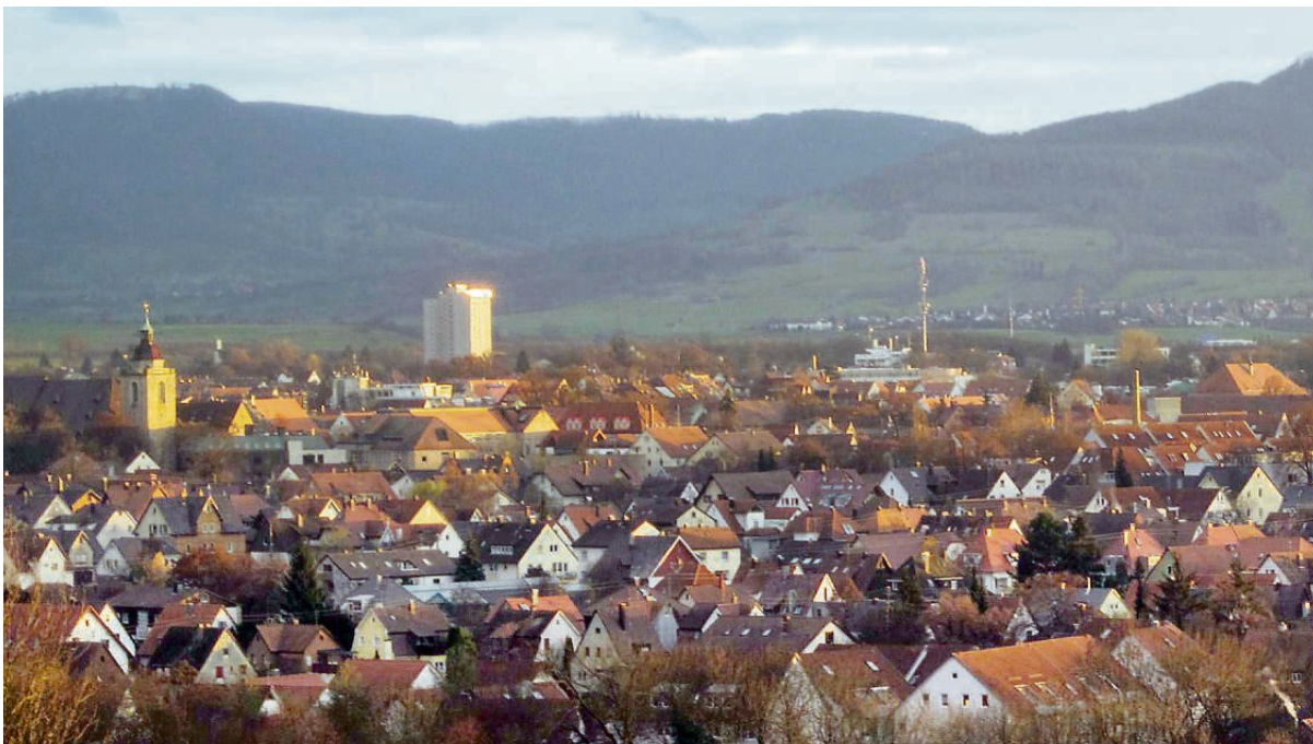
In Kirchheim unter Teck (Landkreis Esslingen) wird die Dachinstandsetzung der Martinskirche vom Land gefördert. FOTO: DPA
