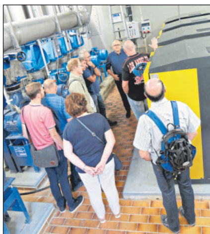
Abwassermeister Thomas Kühner erläutert die Energieeinsparungen im Bereich der Pumpen. Foto: Stadt Winnenden
