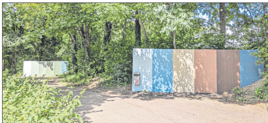
Die Betonwände fügen sich nun optisch perfekt in ihre Umgebung ein. Foto: Schule am Jakobsweg
