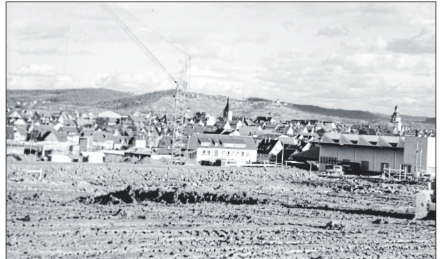
Das Industriegebiet während der Bauarbeiten der Firma AEG um 1962.
