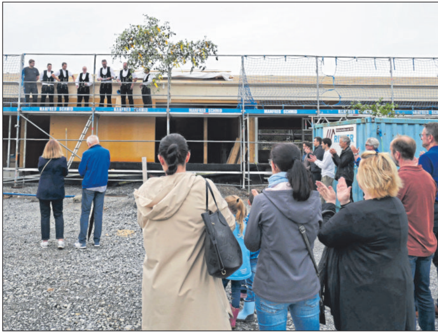
Applaus nach dem Richtspruch durch die Firma Rikker Holzbau.
