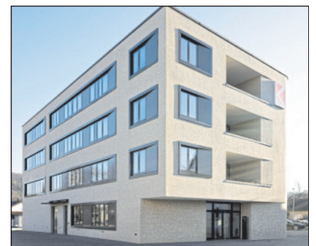
Neues Verwaltungsgebäude an der Talaue in Birkmannsweiler.
